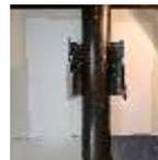
Die UBA-KS-Platte wird an den Rändern etwas eingebogen, um das Rohr gelegt und um das Rohr gebogen
