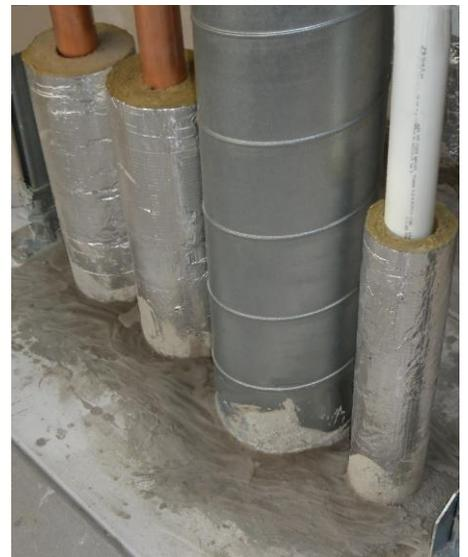
Die einfache Montage ohne Wickeldraht um die Rohrschalen erleichtert die Anordnung neben größeren Dimensionen. Damit werden kostenintensive Montagezeiten eingespart. Gleichzeitig reduziert es das Risiko, bei der Montage die Alukaschierung zu beschädigen.
