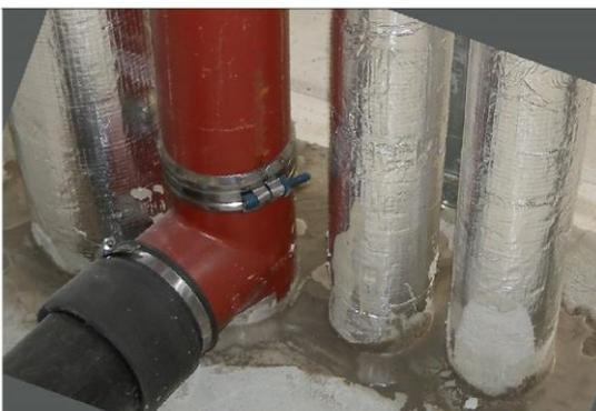
**Fazit: Eine Mischinstallation (Materialwechsel) in der Hausentwässerung ist einfach und ohne größeren Montageaufwand mit dem Brandschutzverbinder zu lösen. Daneben können die Trinkwasser/Heizungsleitungen ohne großen Montageaufwand im Abstand von 2 cm verlegt werden. Ein einwandfreier Deckenverguss ist damit einfach und wirtschaftlich herzustellen.**
