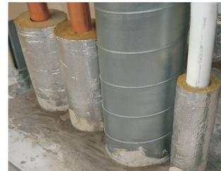
Die Abstände zu Lüftungsleitungen (DIN 18017) betragen 20 mm im Deckendurchbruch.
