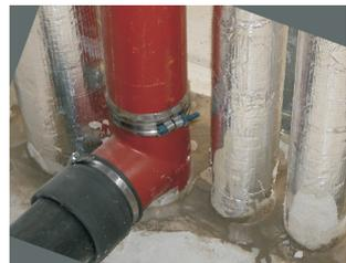
Die Abstände zu Trinkwasser/Heizung/Gasen betragen 20 mm innerhalb der Decke. Dadurch kann der Beton im Deckendurchbruch für einen dichten Deckenverguss sicher eingebracht werden.
