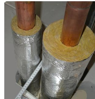
Der 20 mm Abstand kann einfach gemessen werden. Zollstock locker zwischen die Rohrschalen geschoben entspricht ca. 20 mm.
